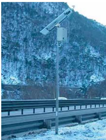
smettere i dati raccolti al centro operativo e di inviare gli eventuali SMS di allarme agli addetti della sicurezza stradale di una videocamera digitale per dare modo al centro operativo di visualizzare la situazione e di un pannello solare con batterie di supporto.
