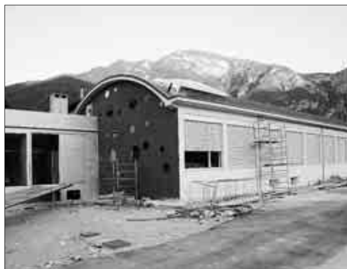
A MATTARELLO. Laboratori in costruzione (Fotoservizio Piero Cavagna)
